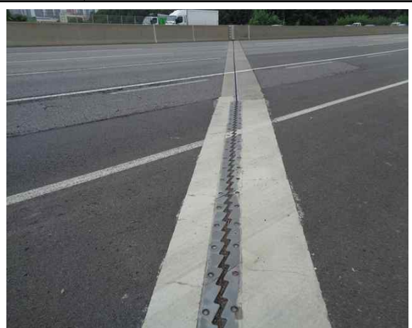
위 치 신축이음 현 황 전경
