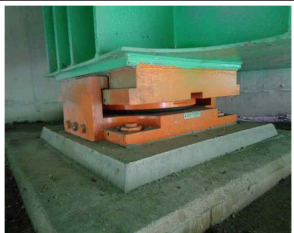
위 치 교량받침 현 황 전경
