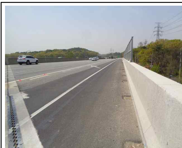
위 치 교면포장 현 황 전경
