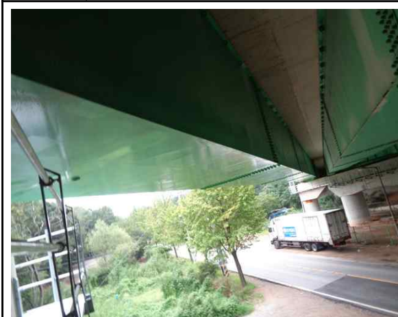
위 치 거더외부 현 황 전경
