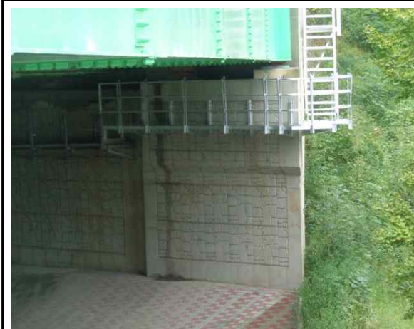
위 치 교대 현 황 전경
