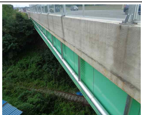
위 치 배수시설 배수관 현 황 전경
